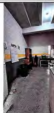
Foto 2: DEMOLICIÓN DE MESAS DE CONCRETO EN DESUSO DE GABINETES PEQUEÑOS EN COCINA. INSTALACIÓN DE ESTUFAS Y CAMPANA EXTRACTORES DE OLORES
