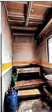
Foto 1: LIMPIEZA Y PINTURA DE TECHO Y PAREDES DE COCINA
