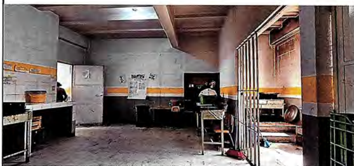
Foto 3: SUSTITUCIÓN EN ÁREA DE COCINA
