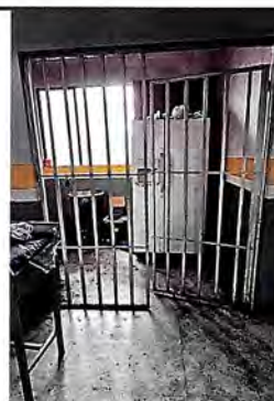
Foto 4: INSTALACIÓN DE PUERTA CORREDIZA EN ALUMINIO NEGRO. REJA DE SEGURIDAD CON CHAPA
