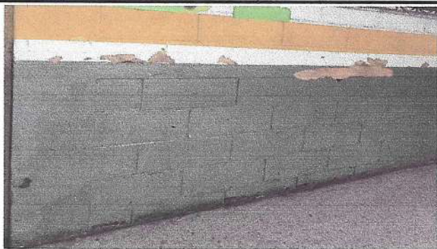
Foto 3: Pintura de agua blanca
