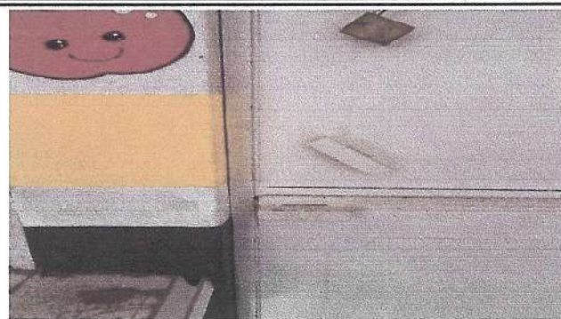
Foto 8: Instalación de chapa
