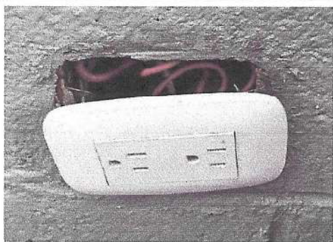
Foto 7: Cambio e instalación de tomacorriente
