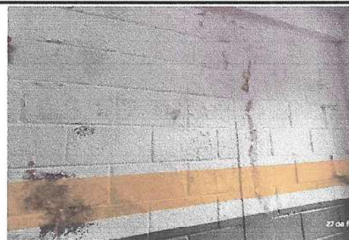
Foto 6: Impermeabilizante y pintura de agua
