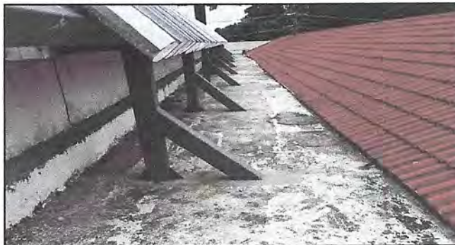
Foto 6: Impermeabilización de losa a dos manos de: canales con dimensiones de 0.40mX30m, mas areas de losa con dimensiones 64.30mX2.60m que suman un area total de 179m2.
