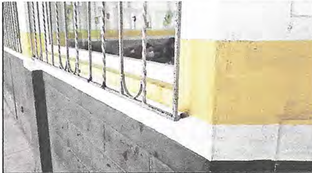
Foto 4: Mantenimiento de balcones en 2 ventanas existentes lijado, cepillado y aplicación de soldadura en pines desprendidos mas pintura a dos manos.
