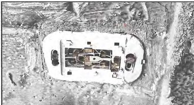
Foto 3: Sustrucción de 20 tomacorrientes dobles en aulas.
