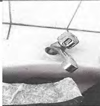
Foto 2: Sustrucción de accesorios hidraulicos de 5 lavamanos que consiste en: llave de grifo, tubo de abasto, contrallave.
