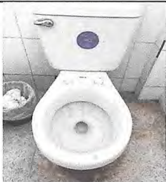
Foto 1: Sustrucción de 7 tapaderas en area de baños
