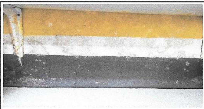
Foto 9: Limpieza, sustitución de repello y aplicación de impermeabilizante de las paredes de la cocina
