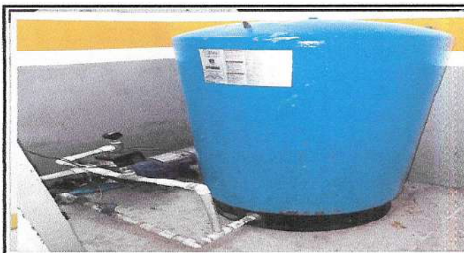
Foto 16: Sustitución de tanque hidroneumático
