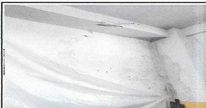
Foto 12: Limpieza, sustitución de repello y aplicación de impermeabilizante de las paredes de aulas de clase
