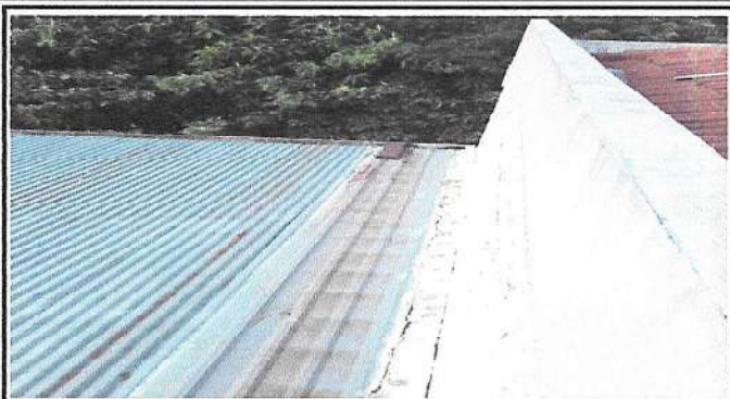
Foto 2: Limpieza, repello en muro y aplicación de impermeabilizante de pared externa de escuela de 6.70 de largo x 2 de alto
