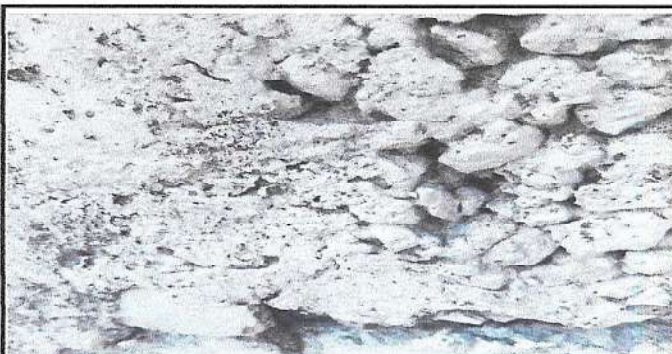
Foto 6: Limpieza, repello en muro y aplicación de impermeabilizante de pared externa de escuela
