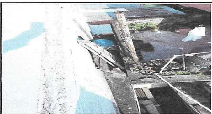
Foto 3: Limpieza, repello en muro y aplicación de impermeabilizante de pared externa de escuela de 3.60 de alto x 6.20 de largo
