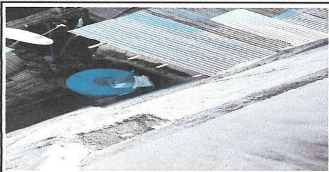
Foto 5: Limpieza, repello en muro y aplicación de impermeabilizante de pared externa de escuela de 7.50 de alto x 2 de largo
