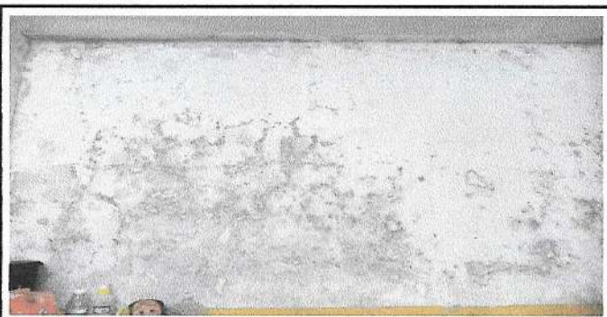
Foto 11: Limpieza, sustitución de repello y aplicación de impermeabilizante de las paredes de la cocina
