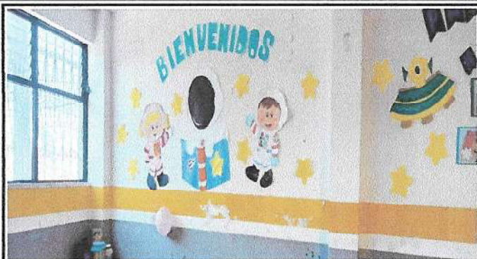
Foto 13: Limpieza, sustitución de repello y aplicación de impermeabilizante de las paredes de aulas de clase
