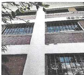
Foto 3: Pintura para fachada, columnas y vigas
