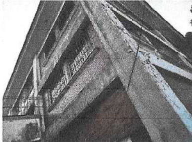
Foto 4: Pintura para fachadas columnas y vigas
