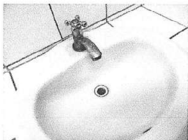
Foto 3: Sustrucción de accesorios varios: llave de lavamanos y accesorios
