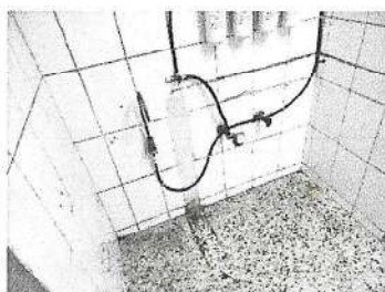
Foto 5: Instalación de azulejos en área de filtros de agua
