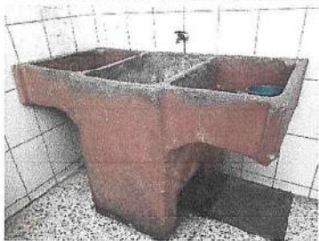
Foto 5: Sustrucción de accesorios varios. Pila de concreto
