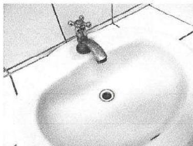
Foto 4: Sustrucción de accesorios varios, llaves de lavamanos y accesorios
