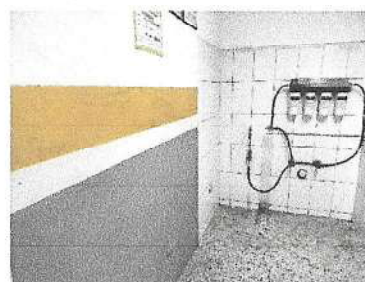
Foto 6: Instalación de azulejos en área de filtros de agua
