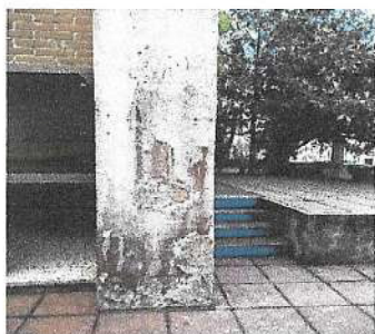
Foto 1: Resanado de columna y viga
