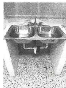
Foto 2: Sustitución de accesorios varios, sofón para doble fosa de avatrasos y accesorios
