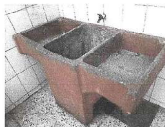
Foto 6: Sustrucción de accesorios varios. Pila de concreto
