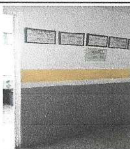
Foto 3: Eliminación de pared en área de cocina
