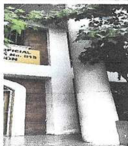
Foto 5: Pintura portal de ingreso
