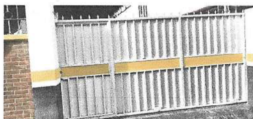
Foto 6: Reparación, mantonimiento y pintura de portón principal
