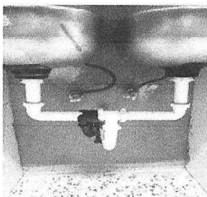
Foto 1: Sustitución de qaccosorios varios, sifón para doble fosa de lavatrasos y accesorios
