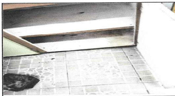
Foto 12. Reparación de mueble fundido colocando grada fundida
