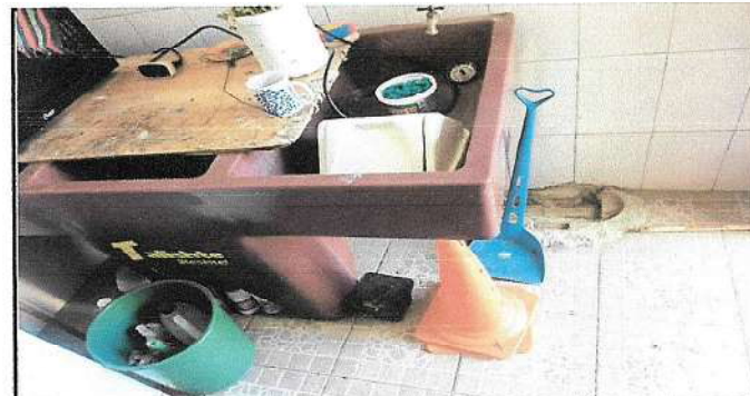
Foto 6. Reparación de drenaje
