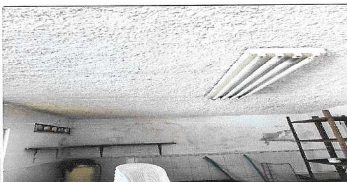
Foto 5. Reparación de cocina
