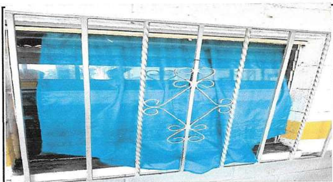
Foto 3. Sustitución de ventanas tipo finish por pvc
