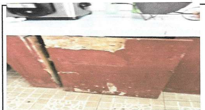
Foto 11. Sustitución de puertas de mueble por puertas de metal
