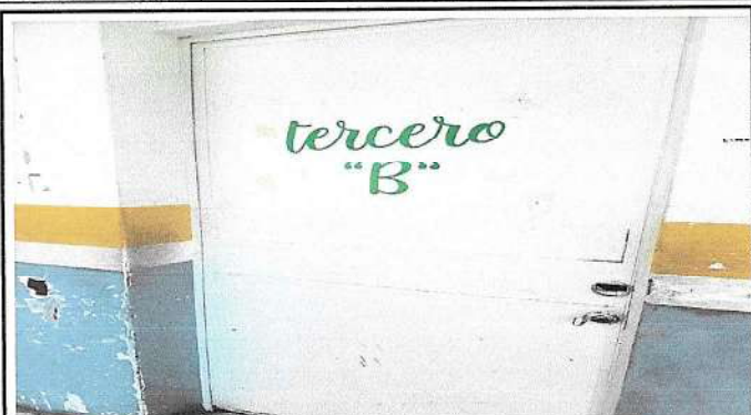
Foto 1. Reparación de puerta
