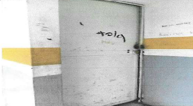
Foto 8. Cambio de chapa y reparación de puerta
