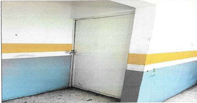
Foto 2. Cambio de chapa
