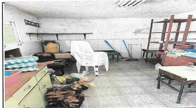
Foto 4. Reparación de cocina
