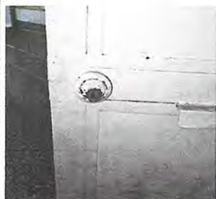
Foto 5: Chapa de puerta, ventana
