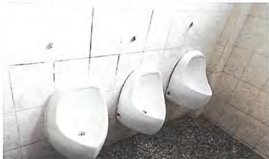
Foto 3: Cambio de mingitorio y accesorios
