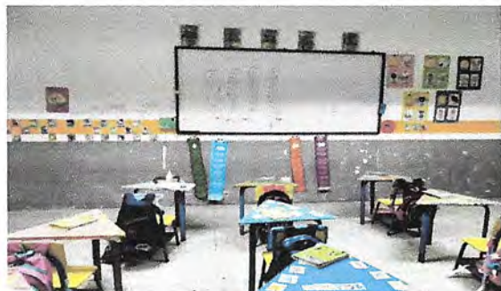
Foto7: Impermeabilización y pintura dentro del salón por filtración de humedad.
