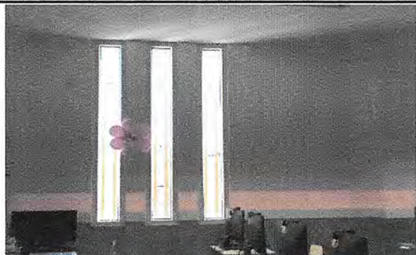
Foto 13: cambio de ventanas en el salón de computación para ventilación.
