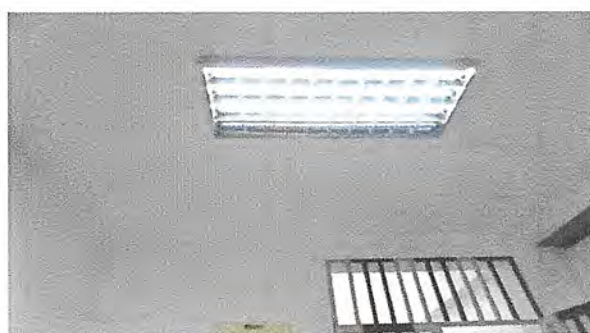
Foto 16: cambio de tubos led en el pasillo cerca de las gradas hacia el segundo nivel.
