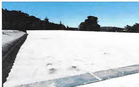
Foto 9: Impermeabilización en área de techo tercer nivel.
