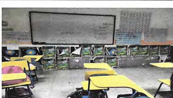
Foto 6: Impermeabilización y pintura dentro del salón por filtración de humedad.
