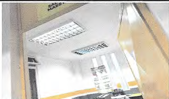
Foto 17: cambio de tubos led en el salón de maestros.
