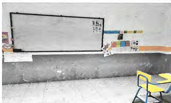
Foto 5: Impermeabilización y pintura dentro del salón por filtración de humedad.
