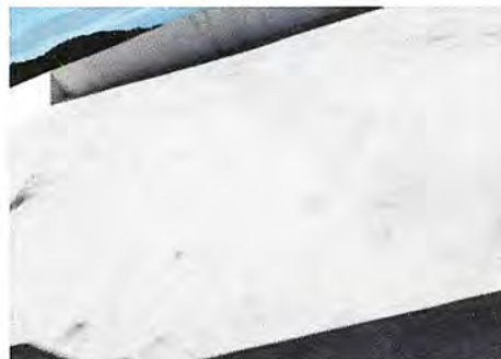
Foto 10: Impermeabilización en área de techo tercer nivel.
