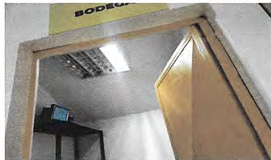
Foto 15: cambio de tubos led en el salón de bodega.
