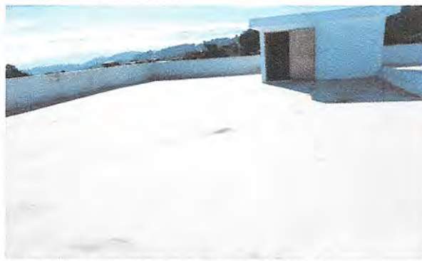
Foto 8: Impermeabilización en área de techo tercer nivel.
