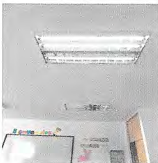
Foto 11: cambio de tubos led en salón segundo nivel aula de sexto primaria
