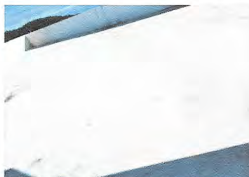
Foto 10: Impermeabilización en área de techo tercer nivel.
