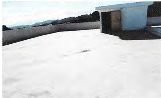
Foto 8: Impermeabilización en área de techo tercer nivel.
