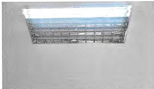
Foto 20: cambio de tubos led en el salón de primero primaria
