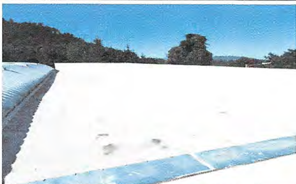
Foto 9: Impermeabilización en área de techo tercer nivel.
