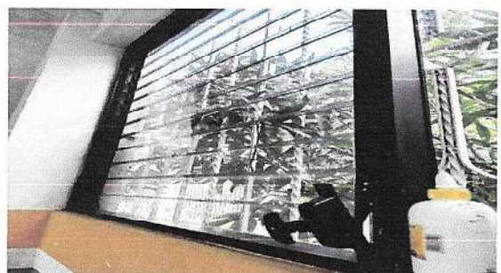
Foto 5: Sustitución de ventana existentes por ventanas de corredizas de PVC con vidrio bronce.
