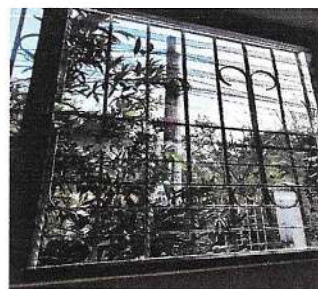
Foto 6: Sustitución de ventanas existentes por ventanas de corredizas de PVC con vidrio de bronce.
