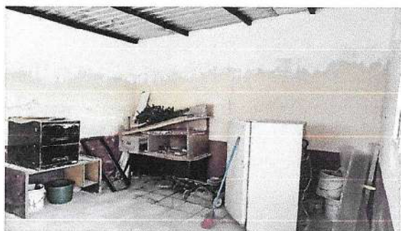
Foto 1, Lado derecho construcción de mueble de cocina aéreo y terrestre en forma de L con puertas de metal en ambos lados.
