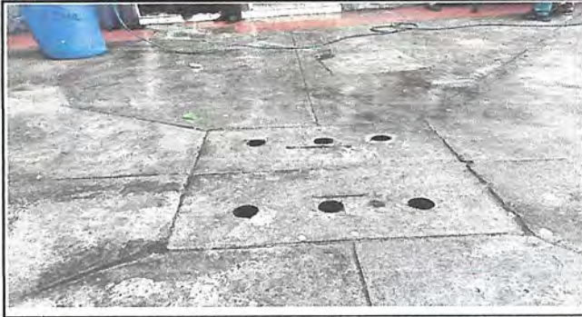
FOTO 10: REPARACIÓN DE AREA DE COCINA (REMOSAMIENTO DE DRENAJES
