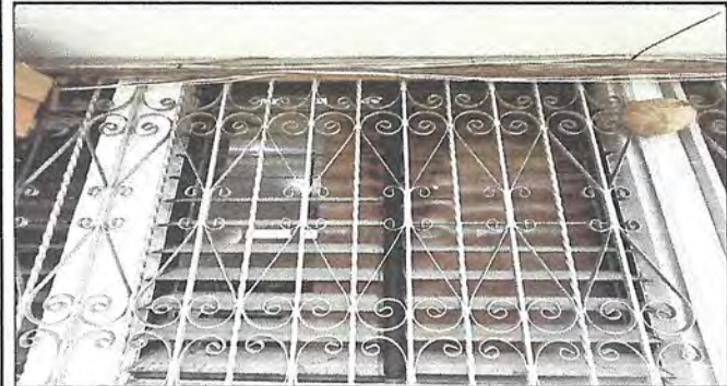
Foto 1 VENTANAS: (Cambio de 17 VENTANAS DE ALUMINO Y PALETAS POR VENTANAS DE PVC)
