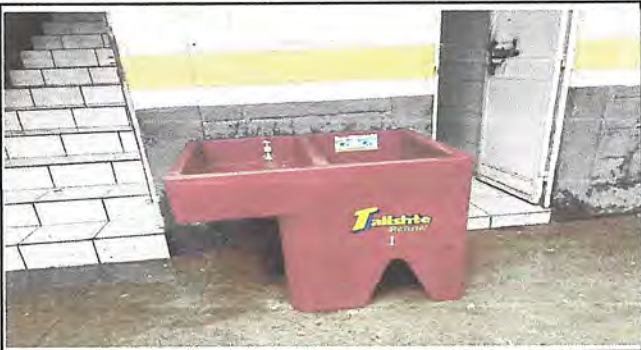
Foto 8: REPARACIÓN DE AREA DE COCINA (INTALACION DE PILAS)
