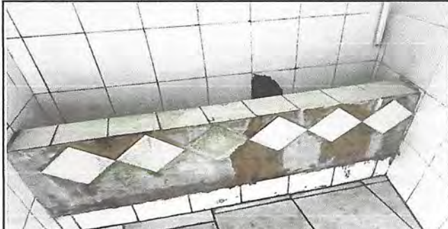
FOTO 6 SERVICIOS SANITARIOS Y SUS ACCESORIOS (CAMBIO DE MIGITOTIO DE CONCRETO, POR MIGITORIOS UNITARIOS)
