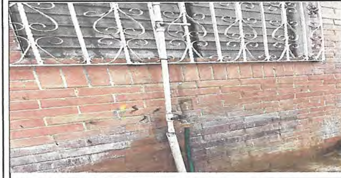
FOTO 11: REMOSAMIENTO DE TUBERIA DE AGUA POTABLE
