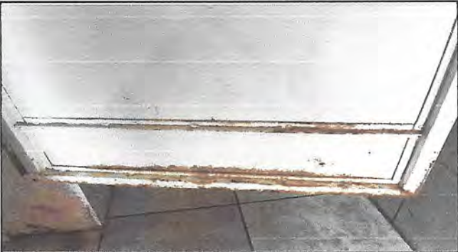
Foto 2: PUERTAS (MANTENIMIENTO DE PUERTAS DE BAÑOS)
