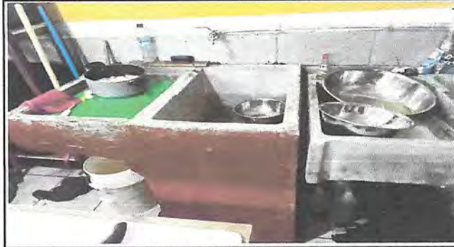
FOTO 12: REPARACION Y SUSTITUCION AREA DE COCINA. (instalación de drenajes y agua potable)
