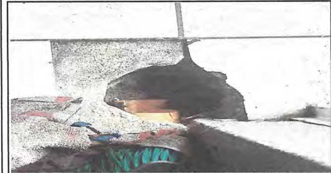
FOTO 9: REPARACIÓN DE AREA DE COCINA (REMOSAMIENTO DE DRENAJES
