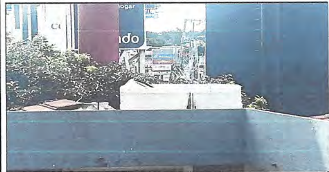
Foto 7: CAMBIO DE DEPOSITO DE AGUA (Cambio de deposito de agua en mal estado)
