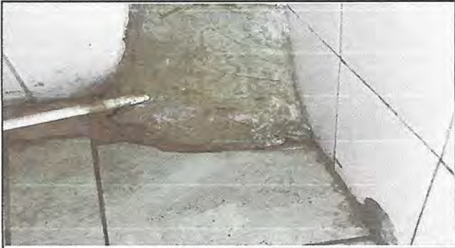
Foto 4: piso (area de baños 20 metros cuadrados )
