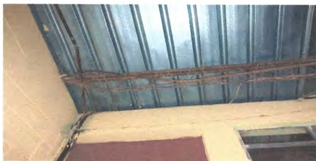
Foto 9: REPARACIÓN DEL SISTEMA ELÉCTRICO - Sustitución de cableado eléctrico por cable calibre No. 12. en salones de preprimaria, bodega y corredor de ingreso.
