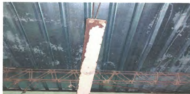
Foto 8: REPARACIÓN DEL SISTEMA ELÉCTRICO - Sustitución de plafoneras en salones de preprimaria, bodega y galera de corredor de ingreso.
