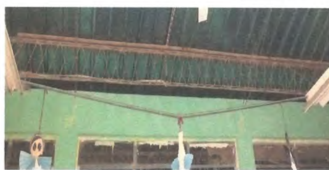
Foto 10: REPARACIÓN DEL SISTEMA ELÉCTRICO - Cambio de ducto eléctrico por tubo gris 3/4 en salones de preprimaria, bodega y corredor de ingreso.
