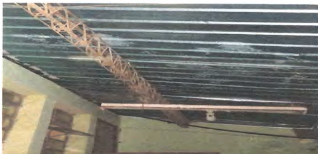
Foto 7: REPARACIÓN DEL SISTEMA ELÉCTRICO - Sustitución de focos por focos led ahorradores en salones de prepa, bodega y galera de corredor de ingreso.
