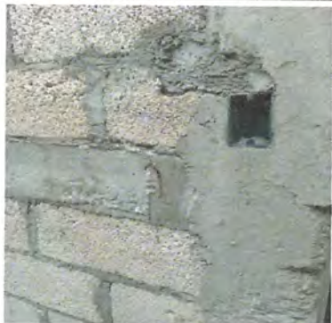
Foto 13: Reparación de sistema de cableado
