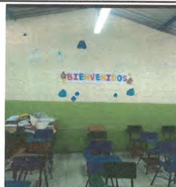
Foto 10: Pintura en aulas interior
