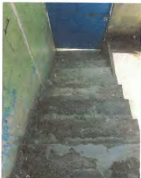
Foto 7: Sustrucción de torta por piso en área de gradas
