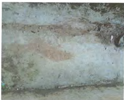
Foto 9: Reparación de cuneta de concreto
