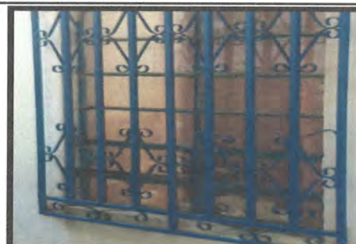
Foto 4: Sustrucción de ventana en Dirección
