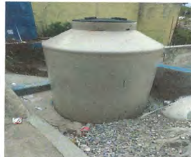
Foto 14: Reparación y mantenimiento de sistema
