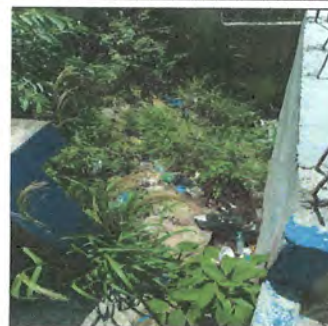
Foto 16: Reparación de cuneta
