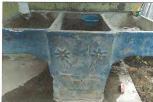
Foto 17: Sustitución de pila
