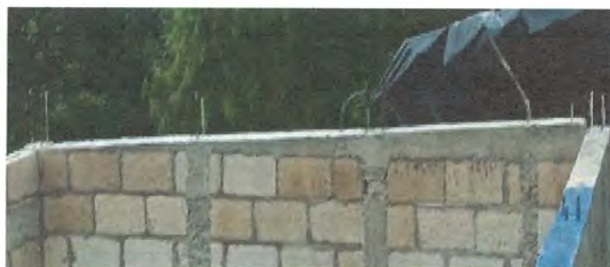
Foto 5: Sustrucción de ventanas en el área de cocina
