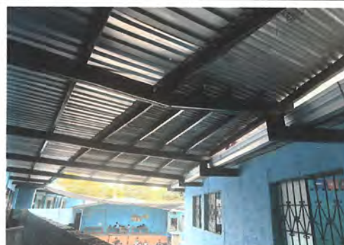
Foto 2: CUBIERTA DE LÁMINA Sustitución de lámina, por lámina troquelada aluzinc calibre 26.
