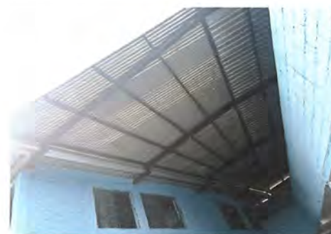
Foto 4: ESTRUCTURA DE TECHO Sustitución de estructura de soporte de metal, por metal.
