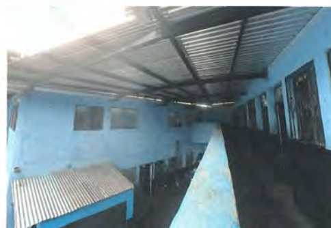
Foto 6: ESTRUCTURA DE TECHO Sustitución de estructura de soporte de metal, por metal.
