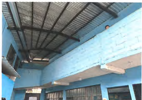
Foto1: CUBIERTA DE LÁMINA Sustitución de lámina, por lámina troquelada aluzinc calibre 26.
