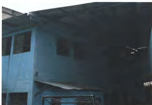
Foto 3: ESTRUCTURA DE TECHO Sustitución de estructura de soporte de metal, por metal.
