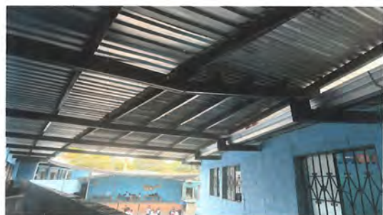
Foto 5: ESTRUCTURA DE TECHO Sustitución de estructura de soporte de metal, por metal.
