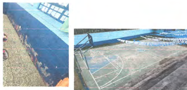
Foto 2: 9.1 Pintura en muros exteriores e interiores
