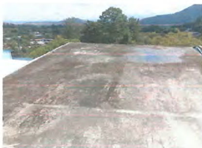
Foto1: 3.1 Impermeabilización de losa
