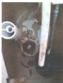
Foto 3: 1 0,2 sustitución de accesorios inodoro ( contra llave,cambio de tubo,tubo de abasto tanque)
