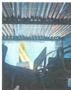
Foto 3: Instalacion de lamina troquelada aluzinc calibre 26
