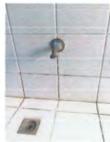
Foto 4: 10.0 sustitución de grifos
