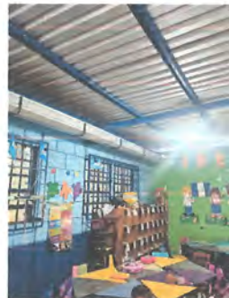
Foto 4: 19.11 Instalacion de unidades de luz (incluye interruptor, ducto cable electrico).
