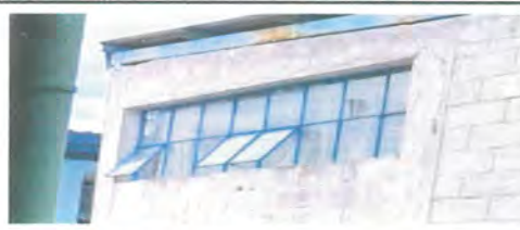
5.5 Sustitucion de vidrios Sustitucion de vidrios quebrados por vidrios transparentes diferentes medidas, aplicación de silicobras transparente para sujetacion.
