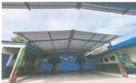
Foto 2: 19.8 Instalación de lámina troquelada aluzinc Instalación de lámina torquelada E25 MAXALUM calibre 26 con tornillos tipo pulser de 5/16 x 2 pulgadas de largo y aplicación de sikflex en tornillos. Area de escenario
