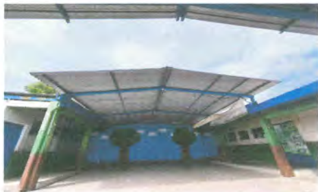
Foto1: 19.7 Instalación de estructura portante de metal Fabricacion e instalacion de estructura portante de metal con soldadura, con tubo cuadrado metal chapa 16 de medidas 2"2 y 3"3 pulgadas con aplicación de pintura color azul institucional. Area de escenario
