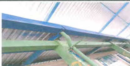
Foto 5 7.4 Sustitución de bajada de agua pluvial de PVC por tubo PVC 3" Sustitucion e instalacion de bajadas de agua pluvial de PVC por tubería de PVC de 3 pulgadas (Incluye tubería de PVC de 3 pulgadas con sus respectivos accesorios, (uniones codos a 45 grados, codos a 90 grados, abrasaderas de hierro plano de 1 pulgada por 1/8 de pulgada, tarugos expandibles y tornillería). Con desfogue a reposaderas, aplicacion de pintura de aceite de secado rapido color azul institucional). Area de patio principal y aulas de primer grado
