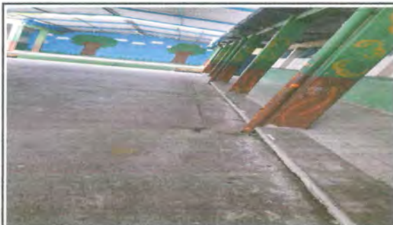
Foto 3: 19.18 Instalacion de tubería principal de pvc Instalacion de red de agua pluvial con tubería PVC de 4 pulgadas pluvial, unidas en cada registro de concreto con desfogue en caja de registro principal existete (Incluye perforacion de piso, sanjeado de tierra, instalacion de tubería pvc de 4 pulgadas con sus respectivos accesorios, retiro de ripio de las instalaciones y sellado de piso con conercro mixto premezclado. Area de patio principal
