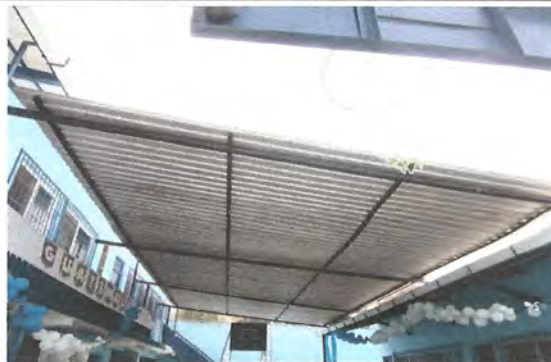
Foto 2: 2.3 Sustitucion de estructura de soporte de metal, por metal.
