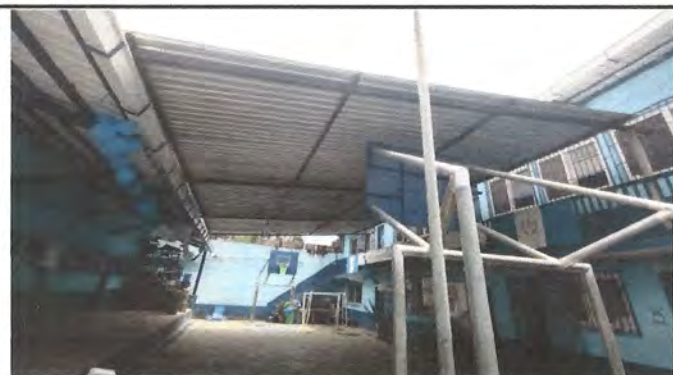
Foto 3: 1.1 Sustitucion de lamina, por lamina troquelada aluzinc calibre 26.
