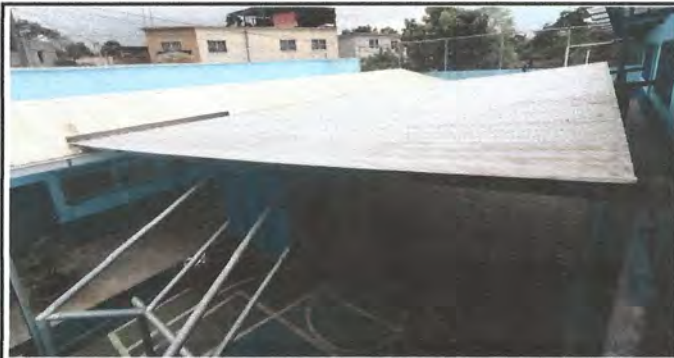
Foto 6: 1.2 Sustitucion de capote de lamina para lamina troquelada.
