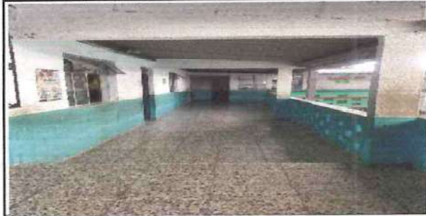
Foto: 12 aplicacion de pintura.
