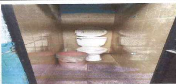
Foto: 3 cambio de sanitario.
