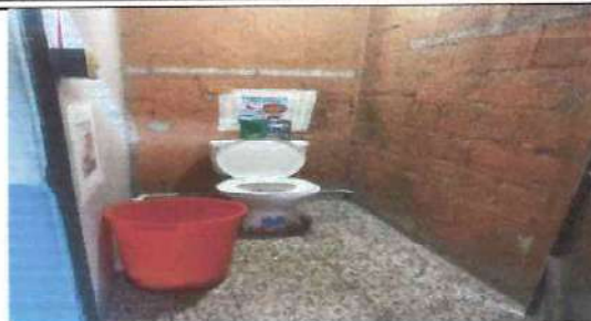
Foto: 2 cernido de paredes de baño..
