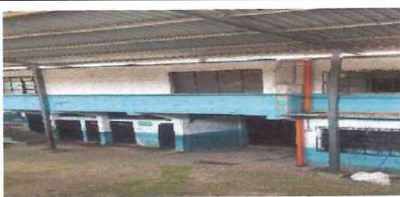
Foto: 8 area de segundo nivel para aplicación de pintura.
