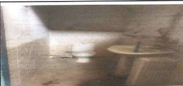
Foto: 5. cambio de baño , cernido de paredes.
