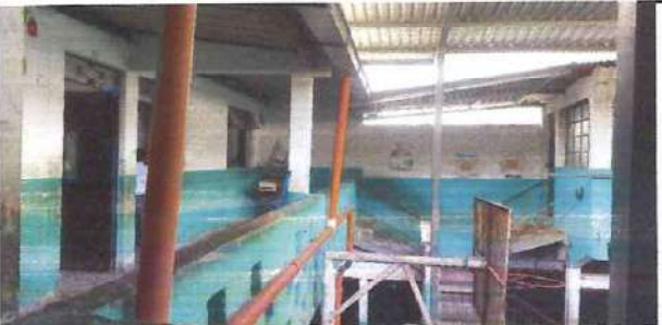
Foto: 13 aplicacion de pintura corredor segundo nivel
