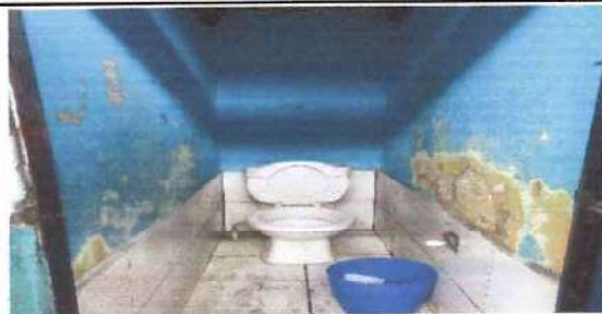
Foto: 1 Sanitario 1 Cernido de paredes.
