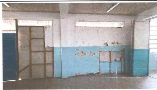
Foto: 6 Reparación de pared en salón de usos múltiples y retirado de puertas de división.
