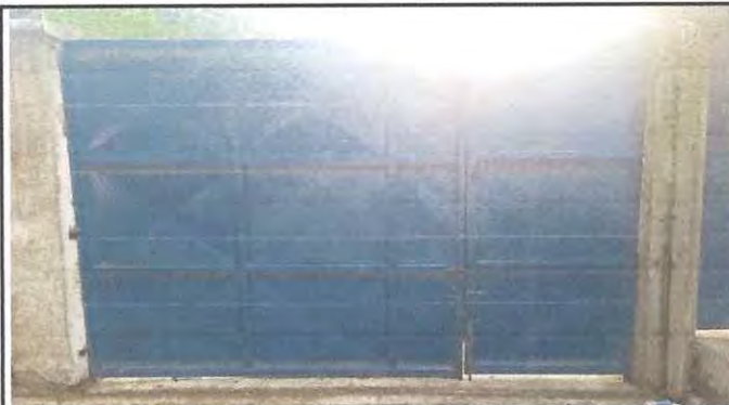
Foto: 4 Reparación y mantenimiento en portón principal
