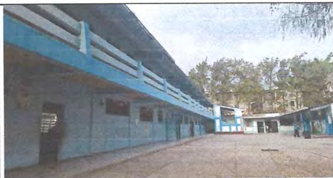
Foto: 5 Pintura general en fachada
