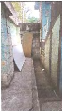
Foto: 1 Colocación de lámina en forma de mini bodega
