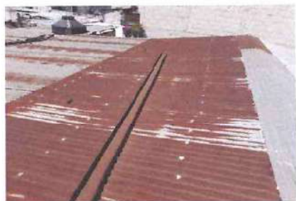
foto 1 techo de aulas
