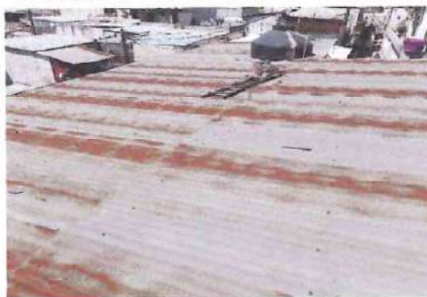
Foto: 2 techo de patio central
