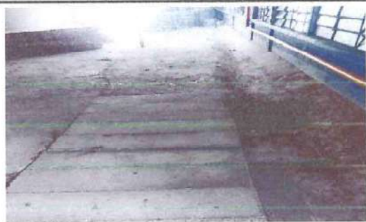
Foto: 1 Eliminación de Fosa Séptica
