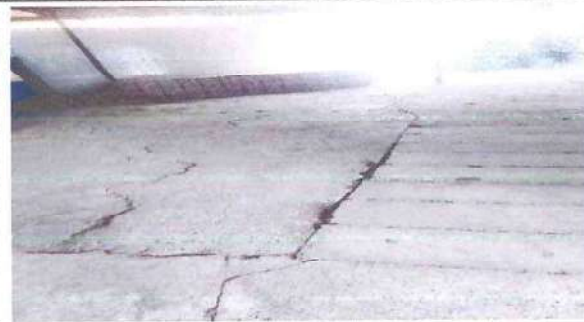
Foto: 2 Patio - Nivelación y alisado
