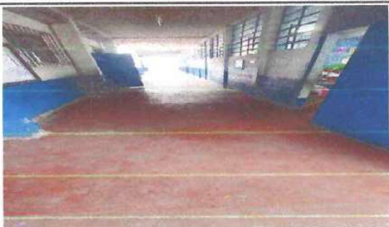
Foto: 3 1er Nivel Piso en pasillo
