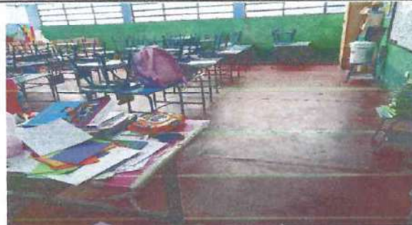
Foto: 4 Primer Nivel Piso en aulas
