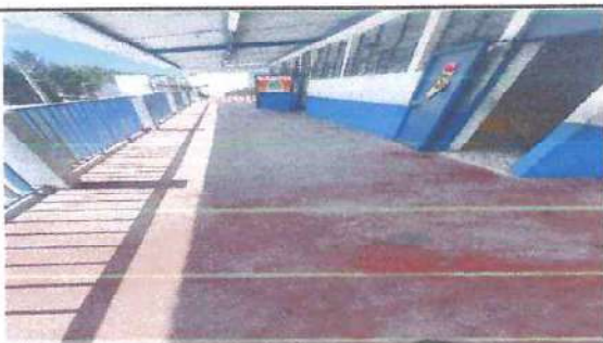
Foto: 5 Segundo Nivel Piso en pasillo
