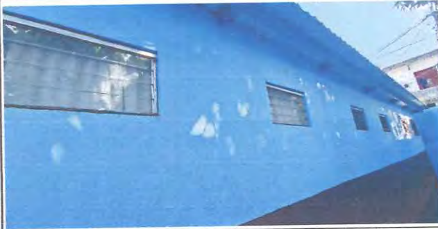
Foto: 7 MODULO 3 - SUMINISTRO DE BALCONES DE AULAS
