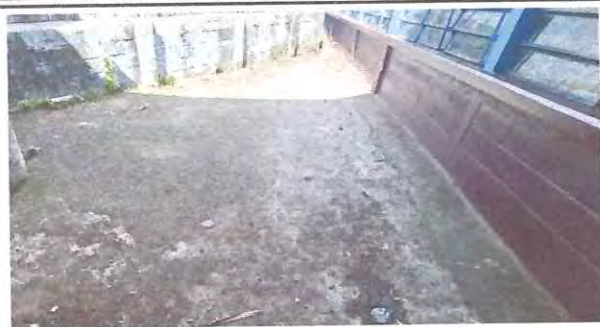
Foto: 13 MODULO 8 - PATIO NIVELACIÓN Y REPOSADERA PLUVIAL
