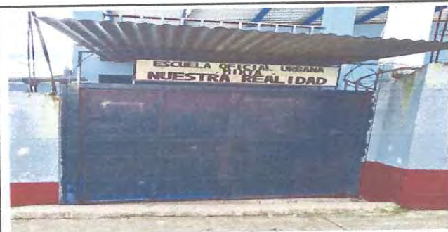
Foto: 9 MODULO 5 - MANTENIMIENTO PORTON INGRESO 1
