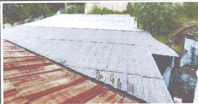
Foto: 2 MODULO 1 - TECHO DE PATIO
