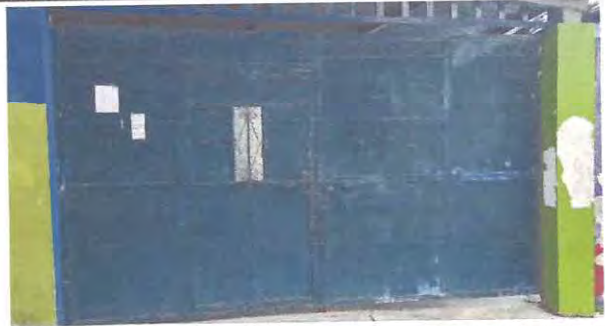
Foto: 10 MODULO 5 - MANTENIMIENTO PORTÓN INGRESO 2
