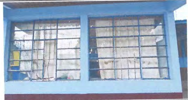
Foto: 8 MODULO 4 - SUMINISTRO DE BALCONES PARA BODEGA
