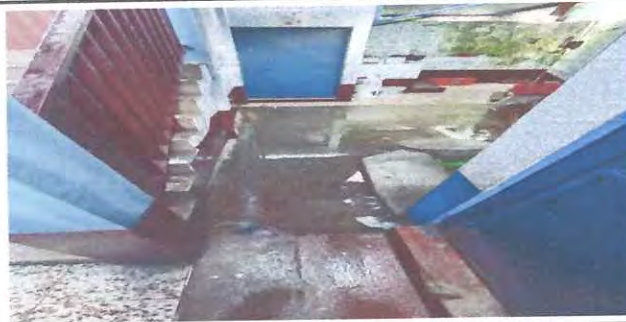
Foto: 11 MODULO 6 - INSTALACIÓN DE TUBERÍA PLUVIAL DE COCINA
