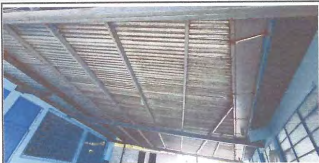
Foto: 1 - MODULO 1 - TECHO DE PATIO
