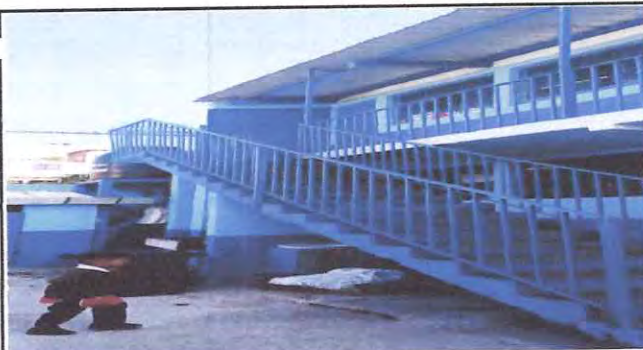
Instalación de Canal y bajadas de agua pluvial
