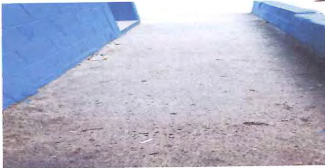
Instalación de piso en pasillo derecho
