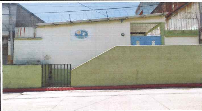
Foto: 1 Pintura General del Establecimiento
