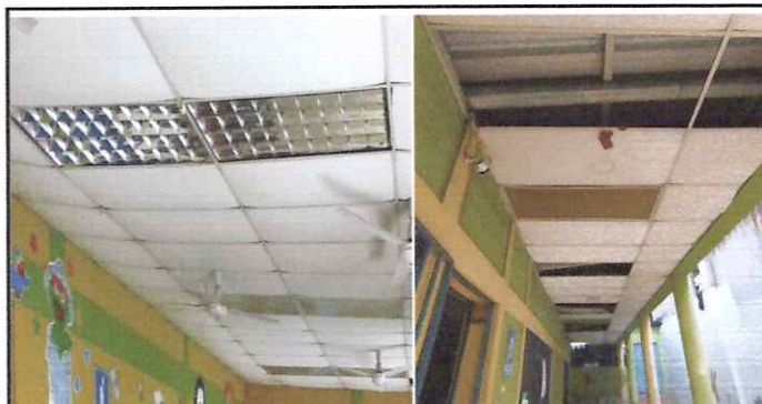
Foto: 4 Servicio eléctrico
