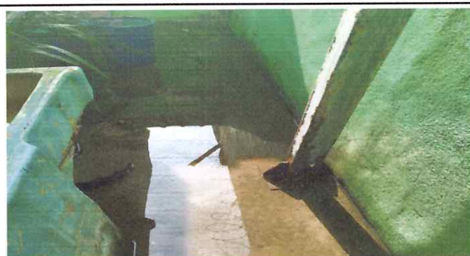
Foto: 3 Limpieza y destape de drenajes interior, exterior
