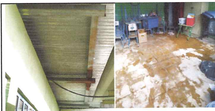
Foto: 5 Techo, canales, repello y cambio de piso
