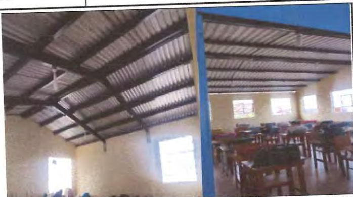
Foto: 2 Area a instalar cielo falso
