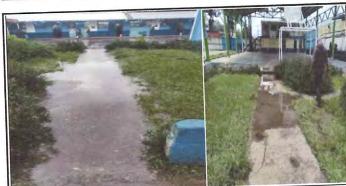
Foto: 6 Remozamiento de pasillo 2
