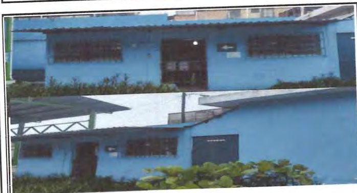
Foto: 3 Canales y mantenimiento de techo
