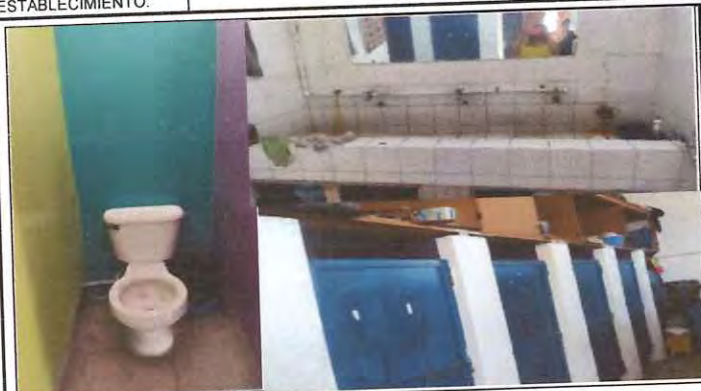
Foto: 1 Cambio de sanitarios
