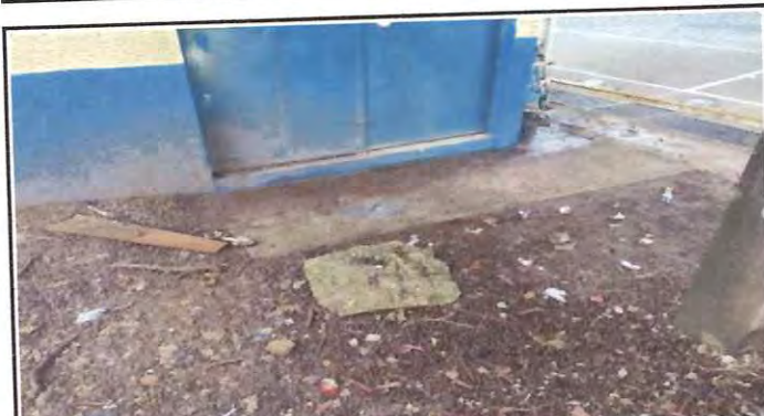
Foto: 4 Remozamiento de pasillo 1
