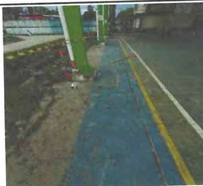
Foto: 4 Rejilla para cuneta
