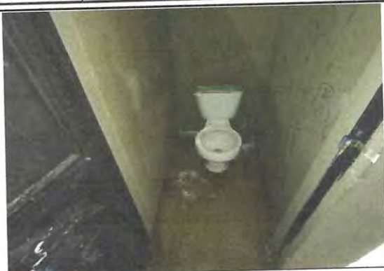
Foto: 1 Reparación de puerta de sanitario
