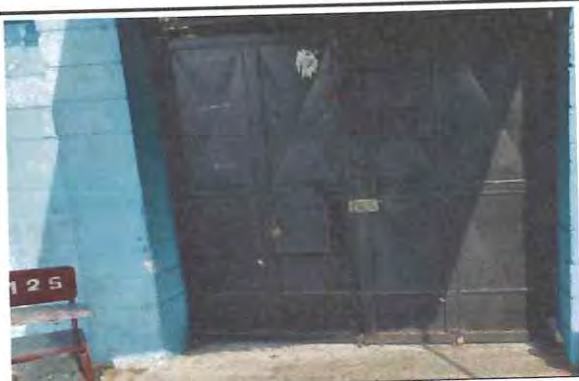
Foto: 3 Sustitución de puerta
