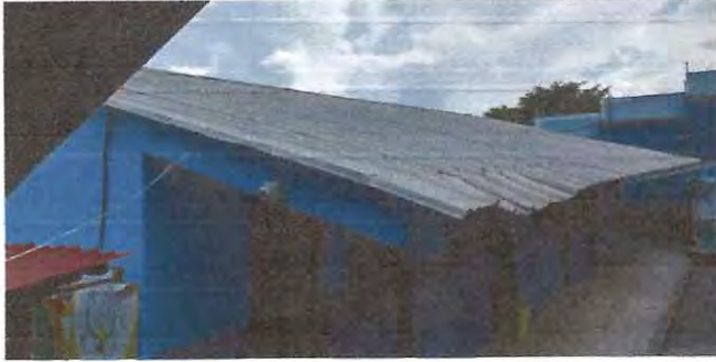
Foto: 1 Cambio de lamina de 3 salones
