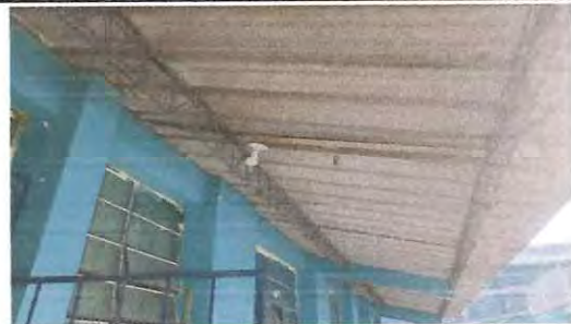
Foto: 4 Cambio sistema electrico
