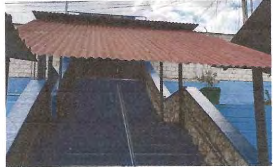
Foto: 2 Cambio de lamina y estructura ingreso a estacionamiento
