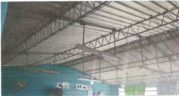
Foto: 5 Cambio sistema electrico
