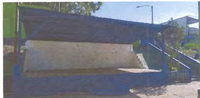
Foto: 4 Escenario que se retocará con pintura de aceite, los parales, láminas y barandas.
