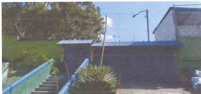
Foto: 3 Portón que se modificará de abatible a corredizo y se modificará la altura
