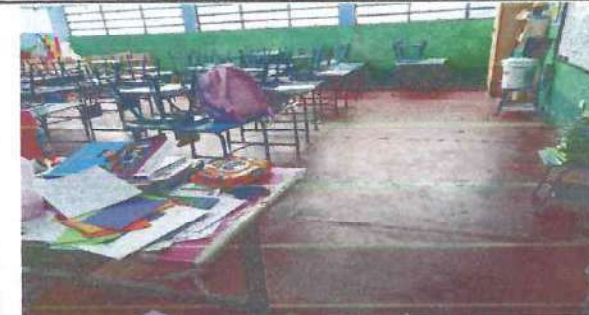
Foto: 4 Primer Nivel Piso en aulas
