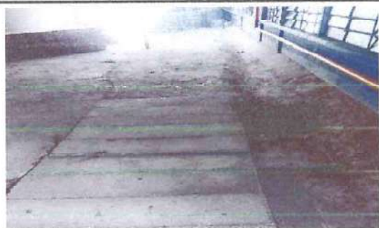
Foto: 1 Eliminación de Fosa Séptica
