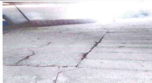
Foto: 2 Patio - Nivelación y alisado
