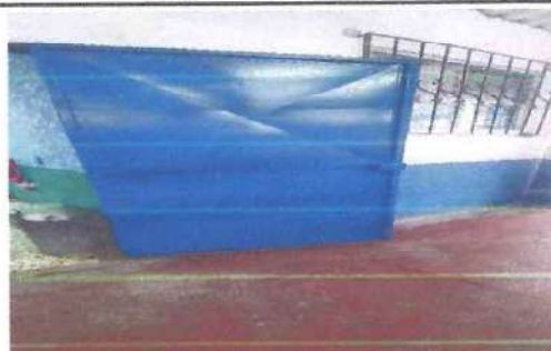
Foto: 6 Mantenimiento en Puertas de aulas 1er. Nivel
