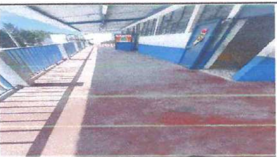
Foto: 5 Segundo Nivel Piso en pasillo
