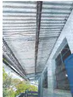
Foto: 4 Mantenimiento y aplicacion de pintura de techo
