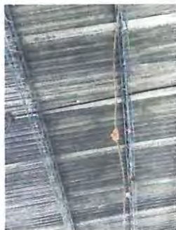
Foto: 3 Cambio de lamina troquelada
