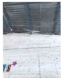
Foto: 5 Instalacion de capote para junta de lamina de techo
