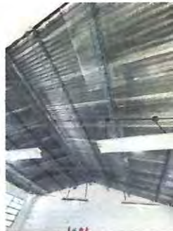
Foto: 2 Instalacion de lamparas tipo led
