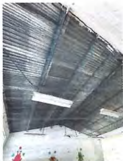
Foto: 1 Cambio de lamina troquelada
