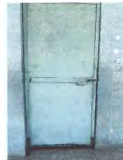
Foto: 6 Mantenimiento de puertas de metal
