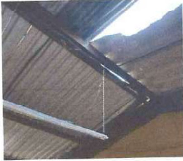
Foto: 1 Cambio de lámina salón 1
