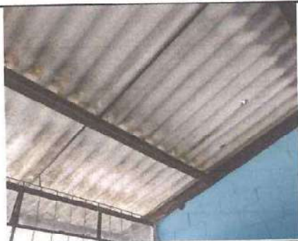
Foto: 6 Cambio de lámina salón 3
