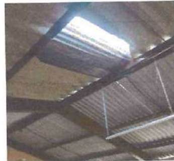
Foto: 2 Mejoramiento del sistema eléctrico
