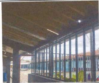
Foto: 4 Mantenimiento de estructura.
