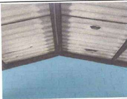
Foto: 5 Cambio de lámina salón 2
