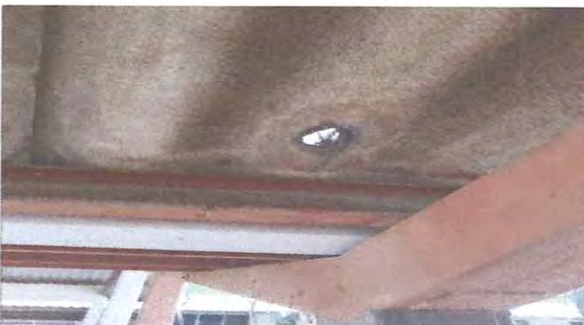
Foto: 4 CAMBIO DE LÁMINA DURALITA EN EL CORREDOR CENTRAL
