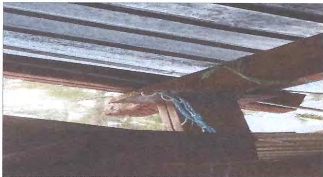
Foto: 3 MANTENIMIENTO DE ESTRUCTURA PORTANTE
