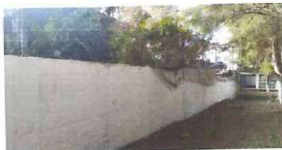
Foto: 2 Muro perimetral
