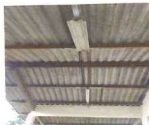
Foto: 4 techado de duralita de corredor de la entrada
