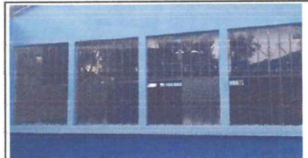
Foto: 6 MANTENIMIENTO DE VENTANA
