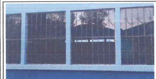
Foto: 5 MANTENIMIENTO DE VENTANAS
