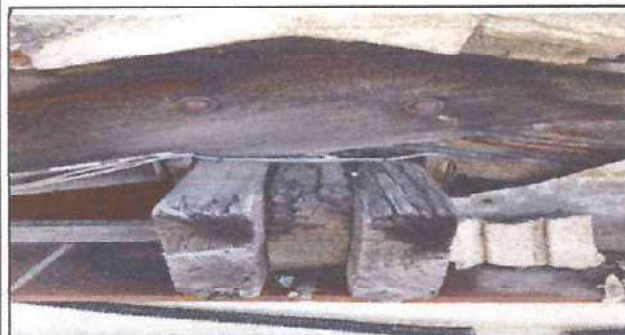
Foto: 3 TECHO VISTO POR FUERA
