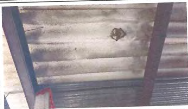
Foto 1: Cambio de lámina de asbesto por lámina aluzinc cal 26
