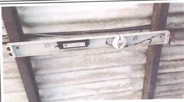
Foto 2: Mejoramiento de luminarias
