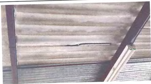
Foto 3: Cambio de lámina de asbesto por lámina aluzinc cal 26
