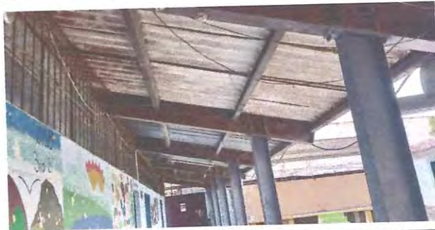
Foto 6: Cambio de lámina de asbesto por lámina aluzinc cal 26, sistema electrico y pintura en estructuras en corredores
