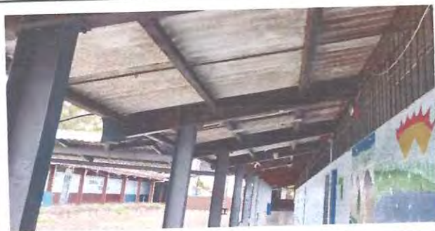
Foto 5: Cambio de lámina de asbesto por lámina aluzinc cal 26, sistema electrico en corredores
