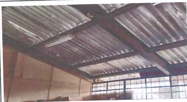
Foto 4: Mantenimiento de estructuras
