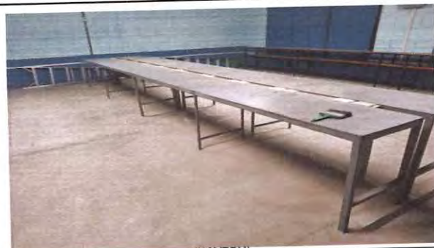
Cambio de piso
