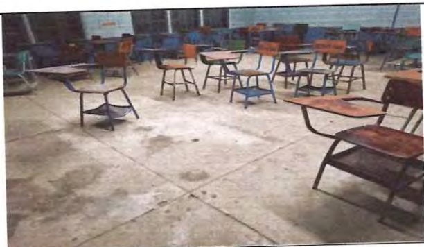
Cambio de piso
