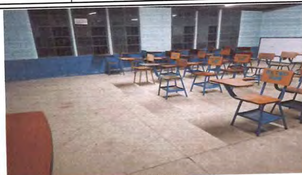
Cambio de piso
