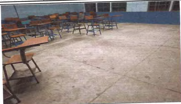
Cambio de piso
