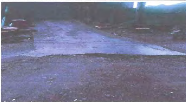
Foto 5: RAMPA DE ACCESO
