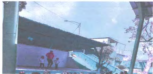
Foto 4: TECHO ENTRE CANCHA Y ESCENARIO E ILUMINACION
