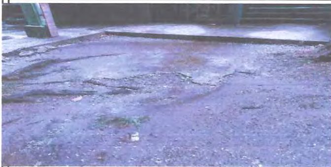
foto 3: RAMPA DE ACCESO
