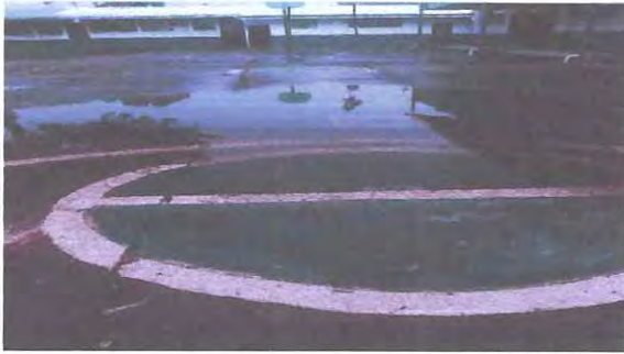
Foto 1: TRAGANTES DE AGUA
