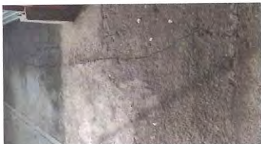
Foto: 7 Cambiar el piso del patio
