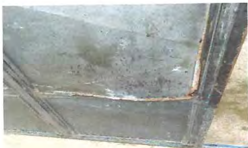
Foto: 5 Cambio de portón.
