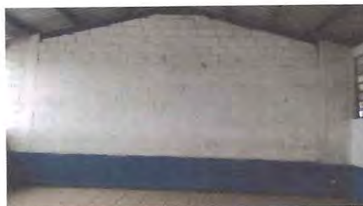
Foto: 10 instalacion de pared con duroc
