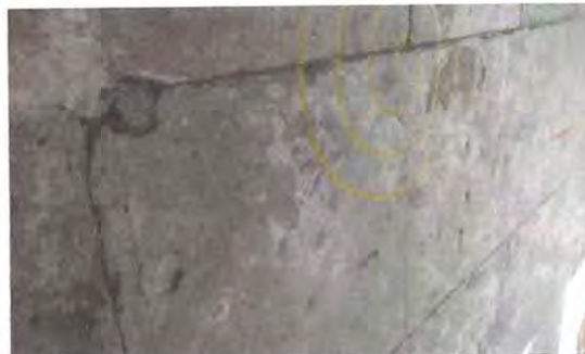
Foto: 8 Instalar nuevo piso en el area del patio
