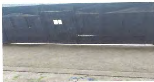
Foto: 6 Instalación del nuevo portón
