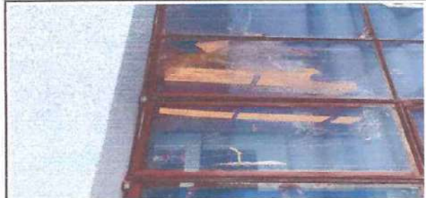
Foto: 6 cambio de vidrios en ventanas
