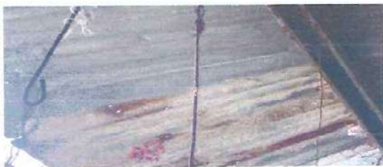
Foto: 5 cambio de lamina primer nivel
