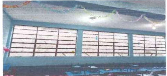
Foto: 2 cambio de ventanas y colocacion de vidrios nuevos
