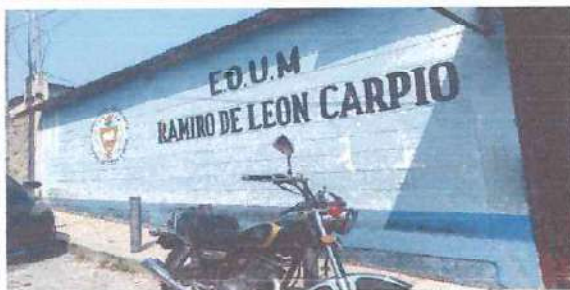
Foto: 3 pintura de en frente
