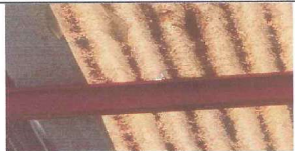
Foto: 4 cambio de lamina y pintura de costaneras
