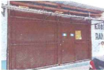
Foto: 3 pintura de portón
