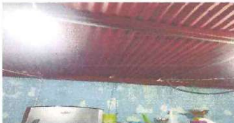
Foto: 5 cambio de lámina y levantado de 2 hojas de pared de block
