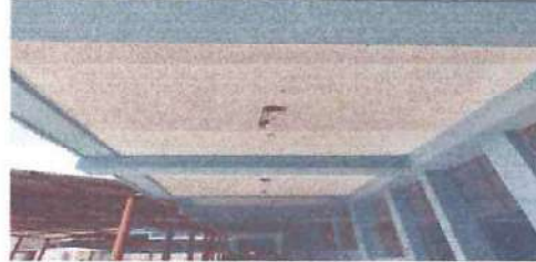
Foto: 2 instalación de luz eléctrica
