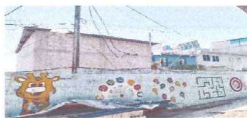
Foto: 6 colocación de lámina muro perimetral
