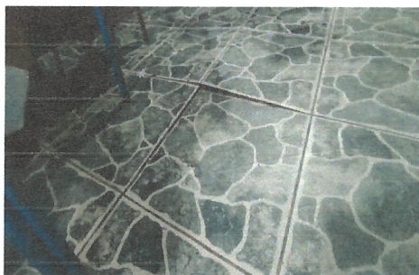
6.8 Sustitución de piso cerámico
