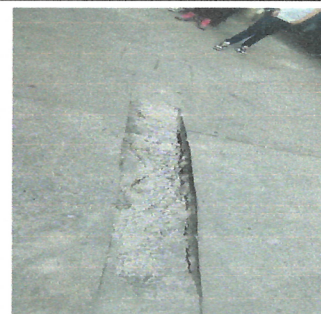
6.1 Reparación de torta de concreto
