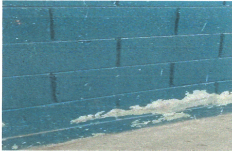
9.1 Pintura en muros exteriores e interiores
