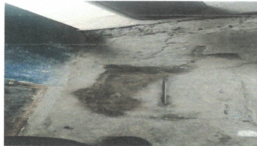
14.3 Sustitucion y mano de obra de tubería pvc aguas negras.
