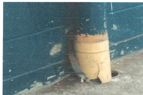
7.3 Reparación de bajada de agua pluvial tubo PVC 3"
