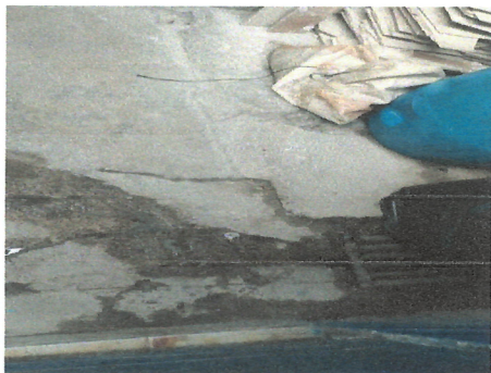
14.3 Mantenimiento a reposaderas
