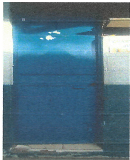
4.1 Mantenimiento a estructura a puertas (lijado, cepillado y aplicación de pintura).
