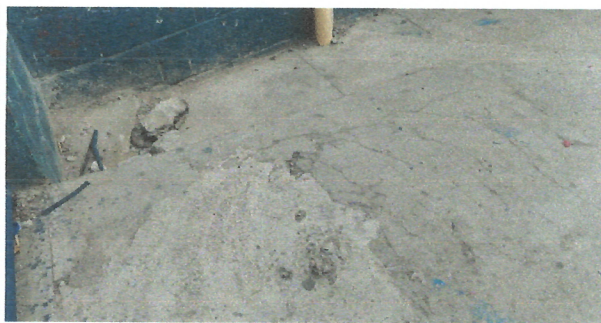
16.1 Reparaciín de planchas de concreto de patio.
