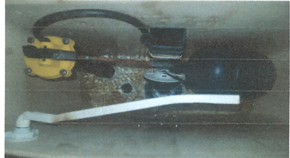
10.2 Sustitucion de accesorios de inodoro y sustitucion de tapadera de inodoro
