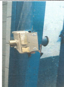
4.2 sustitución de chapa
