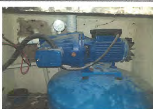
18.6 Reparacion de Bomba de agua
