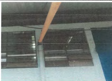
14.4 Sustitucion de tubería PVC línea principal aguas pluviales
