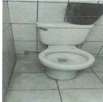
10.3 Sustitucion de inodoro tipo baby.
