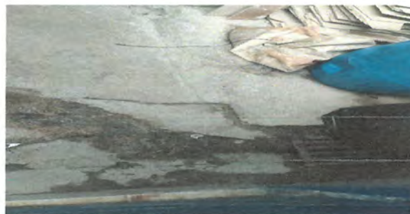
14.3 sustitucion de tubería PVC línea principal aguas negras
