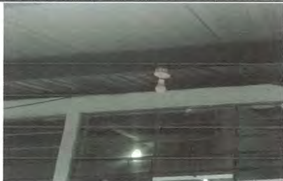
17.4 Sustitucion de focos ahorradores
