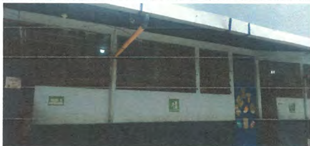
5.2 sustitucion de estructura de metal a ventana PVC y colocacion de balcones
