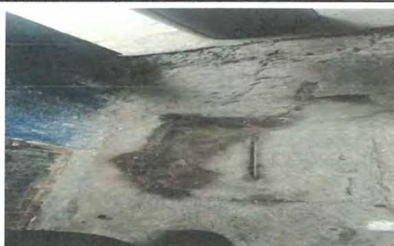
14.8 Sustitucion de caja de registro
