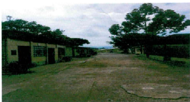
Sustitucion de piso de torta de concreto en el patio principal
