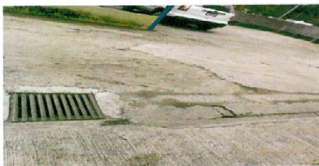
Sustitucion de tubería PVC línea principal aguas pluviales
