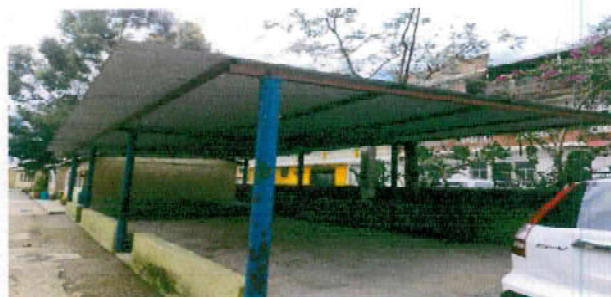
reparacion de plancha de concreto en el patio (donde esta la galera actual)
