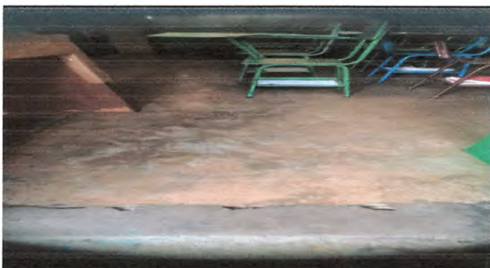
6. Sustitución de torta de concreto por piso cerámico
