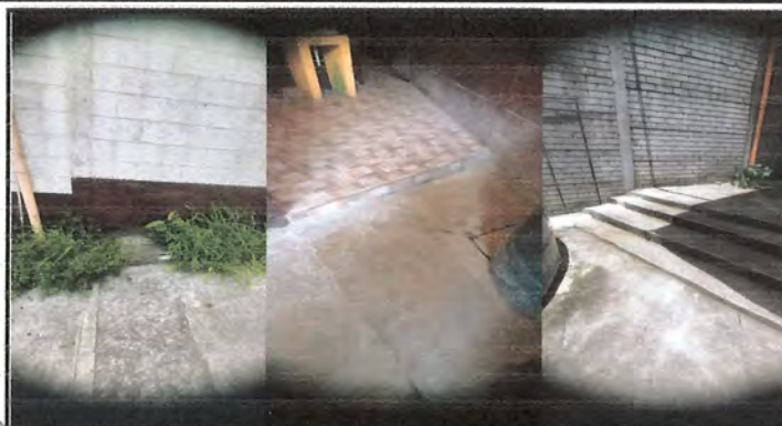
19. Sustitución de gradas por rampas para silla de ruedas
