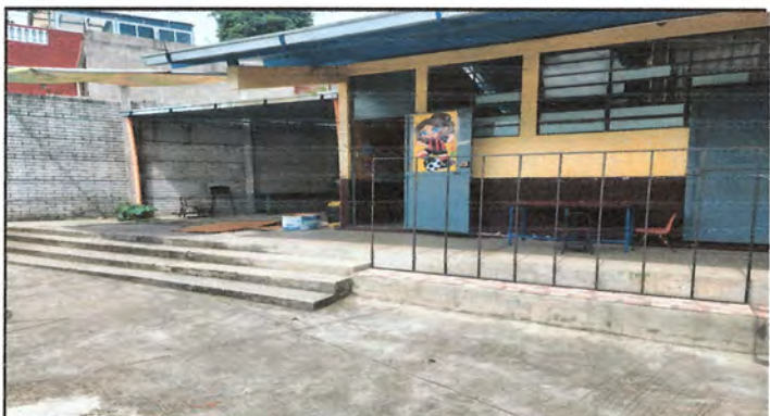
11.2 Sustitución de baranda de seguridad en área superior de banca de concreto
