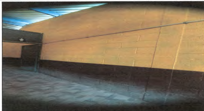
19. Apertura de vano en pared de block para instalación de puerta de metal, incluye demolición mas marco.
