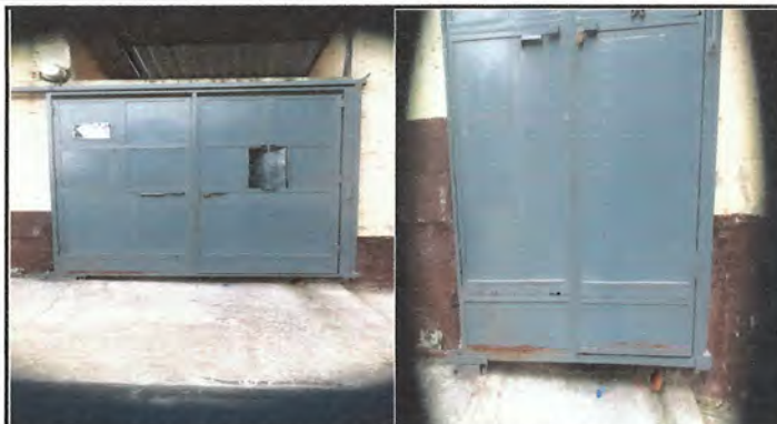
4. Reparación de portón entrada principal y aplicación de pintura anticorrosiva
