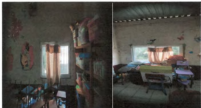
19. Modificación de altura de ventanas, incluye desmontaje, levantado de dos hiladas de block, demolición y resanado para boquetes. Las ventanas se pondrán mas altas por seguridad de los niños y niñas.
