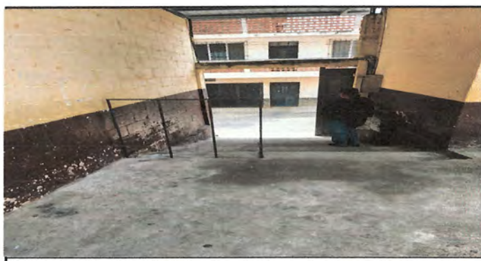
19. Sustitución de salida de gradas por puerta de rejas en 2 hojas con materiales de tubería de 1 1/4 x 1 1/4 con bisagras y pintura anticorrosiva, medidas 1.20 x 1.10 mts
