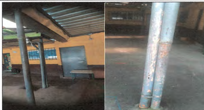
14. Sustitución de tuberías para bajadas de agua.
