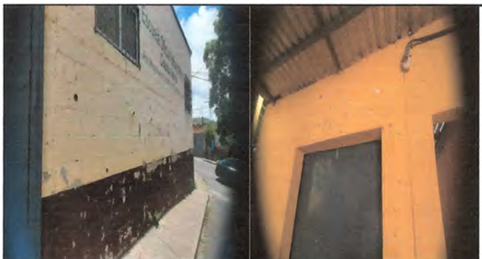
9.1 Suministro y aplicación de pintura calidad Sherwin Williams en 611 m2
