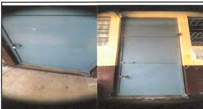
4.1 Mantenimiento y aplicación de pintura en puertas metálicas con medidas 90cm x 2.10 mts
