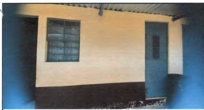
19. Apertura de Vano en pared de block para instalación de ventana corrediza en material PVC con medidas de 1mt x 1mt y vidrio claro incluye tallado y retiro de rípo
