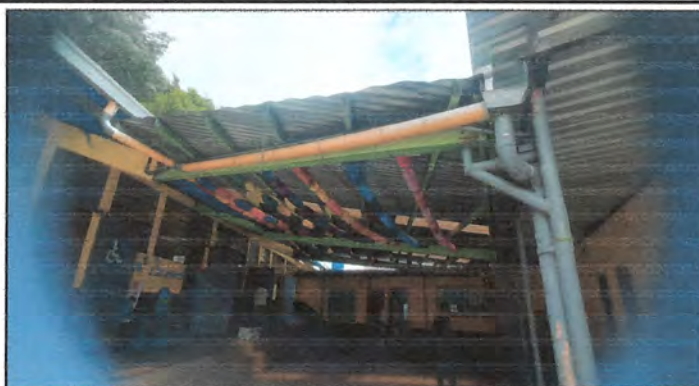
1.1 Sustitución de lámina por lámina Troquelada calibre 26 en área de sombra de patio
