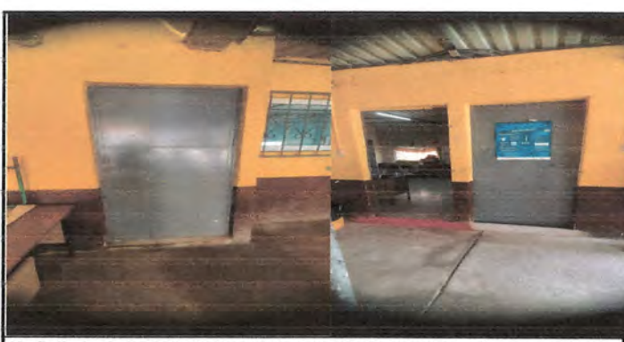
19. Sellado de boquetes de puertas con block, cemento, hierro, repello y pintura
