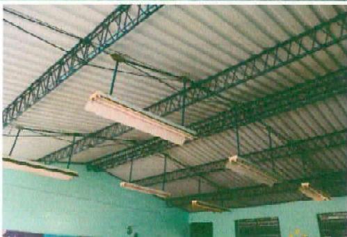
Foto7: Sustitución de plafoneras
