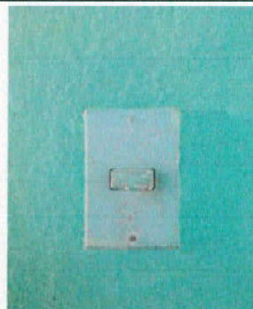
Foto 8: Sustitución interruptores dobles
