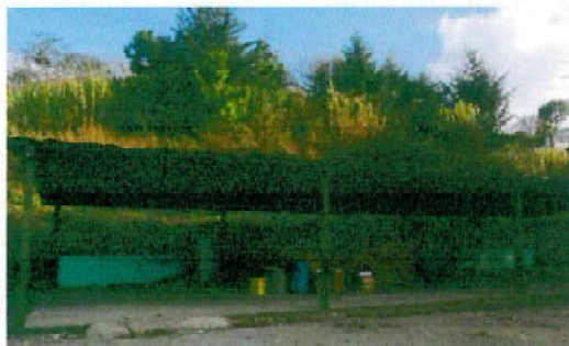
Foto1: Mantenimiento a estructura de soporte de metal
