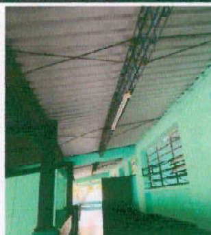
Foto 6: Sustitución de lamparas tipo LED con cableado
