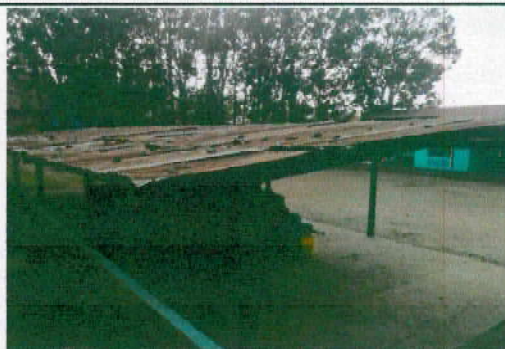
Foto 2: Sustitución de lámina, por lámina troquelada aluzinc calibre 26
