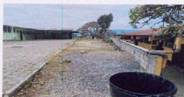
Foto 4: Fundición de losa concreto de patio(grosor 10cms con electromalla)
