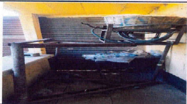
Foto 5: Instalación de pila nueva.
