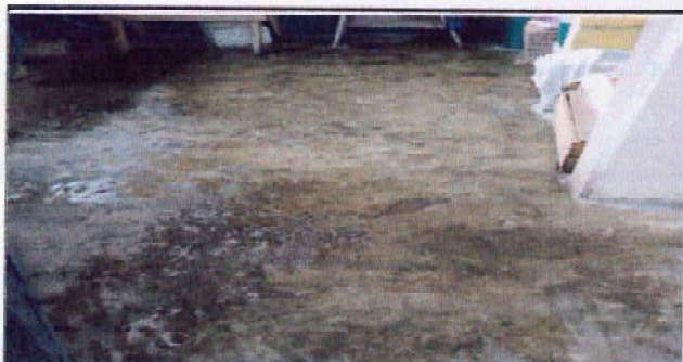
Foto 3: Sustitución de piso por piso cerámico ( cocina)
