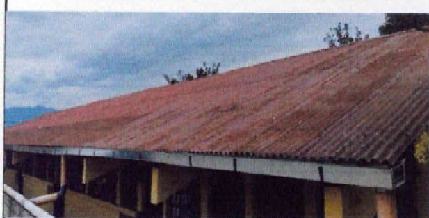
Foto 1: Desmontaje de lámina acanalada e instalación de lámina troquelada aluzinc calibre 26.
