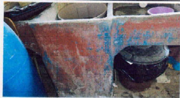
Foto 8: Sustitución de pila por pila de cemento de dos lavaderos.
