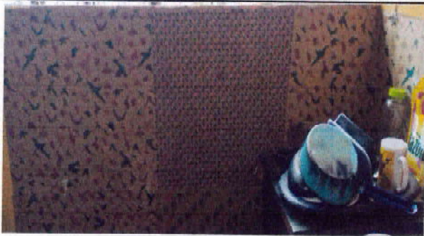
Foto 7: Suministro e instalación de azulejo en pared donde se encuentra la estufa rural.
