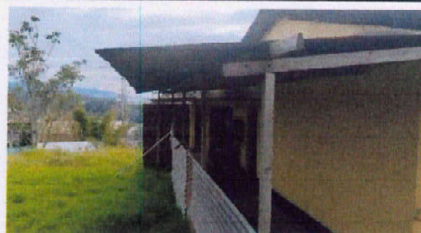
Foto 2: Sustitución de estructura de soporte de madera, por metal (incluye sustitución de lámina por lámina troquelada aluzinc calibre 26.(Pasillo cocina)
