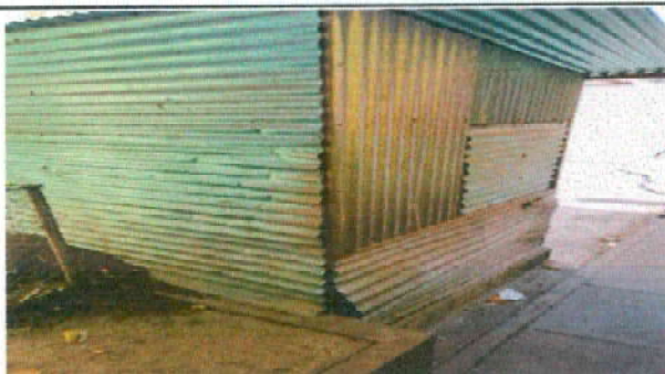
Foto 5: 2.2 Sustitución de estructura de soporte de madera por metal
