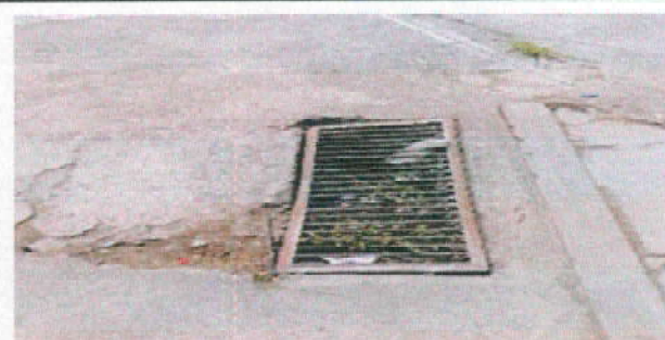
Foto 24: 14.1 Mantenimiento a reposaderas. Limpieza de caja de aguas pluviales.
