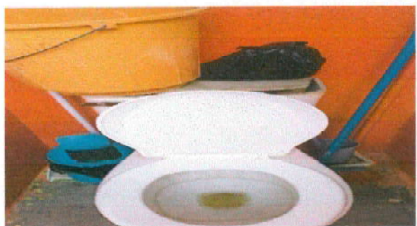
Foto 15: 10.3 Sustitución de inodoro
