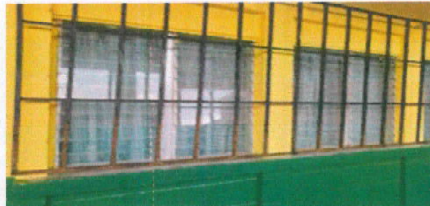
Foto 14: 5.7 Mantenimiento a balcones de metal.
