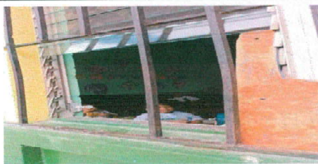
Foto 11: 5.5 Sustitución de vidrio
