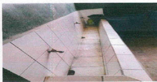
Foto 18: 10.9 Sustitución de grifos
