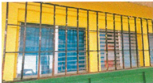
Foto 13: 5.7 Mantenimiento a balcones de metal
