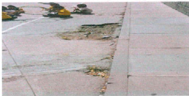
Foto 25: 14.1 Mantenimiento a reposaderas. Limpieza de caja de aguas pluviales.
