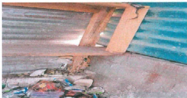
Foto 7: 2.2 Sustitución de estructura de soporte de madera por metal
