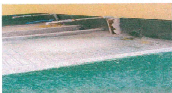
Foto 17: 10.9 Sustitución de grifos
