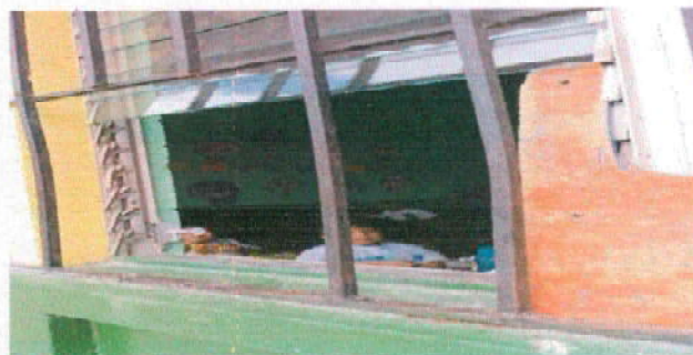
Foto 8: 5.5 Sustitución de vidrios.
