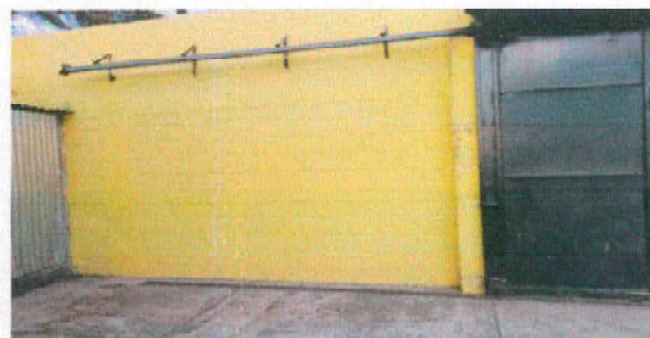
Foto 20: 12.1 Mantenimiento a portones de metal. Cambio de riel, rodos, recibidor angular, nivelación, lijado.
