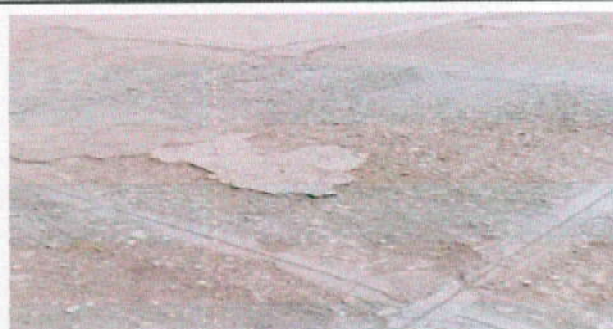
Foto 30: 6.1 Reparación de piso de torta de concreto. Torta de cancha, fundición 10 cms de espesor.
