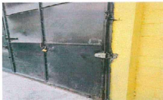
Foto 19: 12.1 Mantenimiento a portones de metal. Portón de ingreso área de parqueo.
