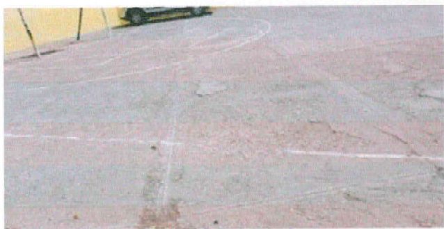
Foto 25: 6.1 Reparación de piso de torta de concreto. Torta de cancha, fundición 10 cms de espesor
