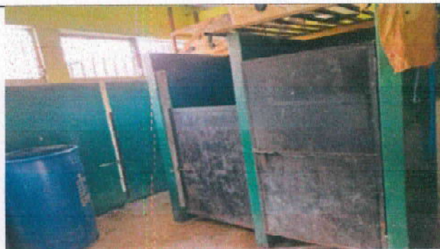
Foto 4: 4.4 Sustitución de puertas en servicios sanitarios
