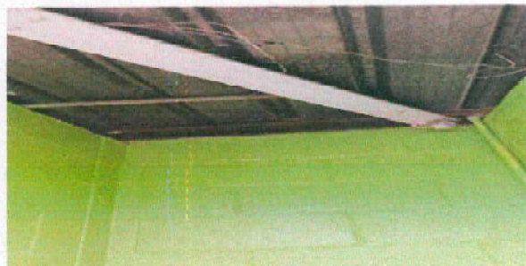
Foto 26: 17.3 Sustitución de lámparas tipo LED
