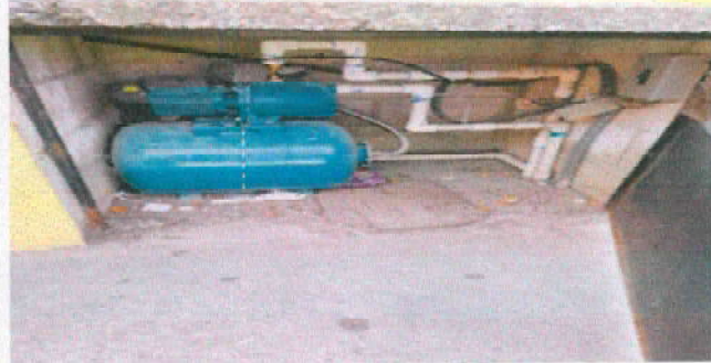
Foto 26: 18 Mantenimiento de cisterna. Mantenimiento a bomba de agua.
