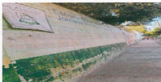
Foto 22: 9.1 Pintura en muros exteriores.
