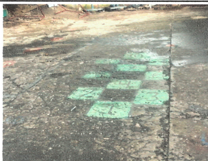
Foto 5: Reparación de plancha de concreto de patio
