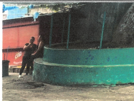
Foto 6: Aplicación de pintura a banca de patio
