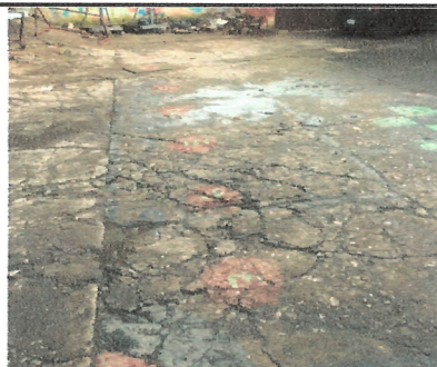
Foto 3: Reparación de plancha de concreto de patio
