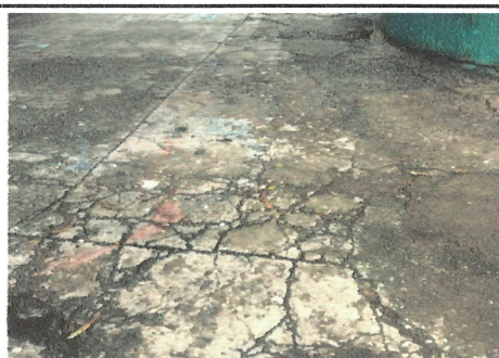
Foto 4: Reparación de plancha de banco de patio
