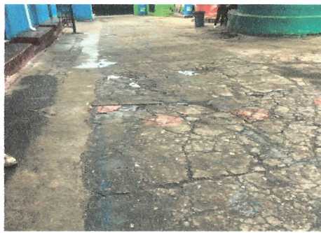
Foto 2: Reparación de plancha de concreto de patio
