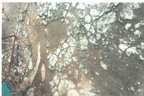
Foto 1: Reparación de plancha de concreto de patio
