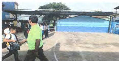
Foto1: Sustrucion de lamina , por lamina troquelada calibre 26
