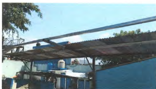
Foto 3: Sustrucion de estructura de metal, por metal con refuerzo de tijeras
