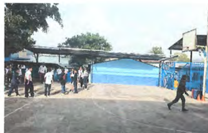
Foto 2: instalacion de costaneras para soporte de lamina
