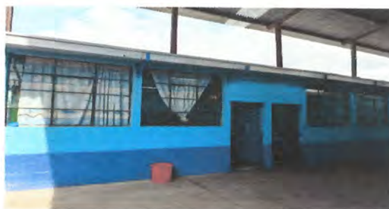
Foto 4: Sustrucion de ventanas de metal , por ventanas de pvc en aulas de primero
