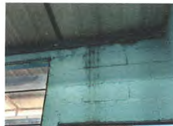
Foto 6: Sellado de lamina en aula de 1ro.
