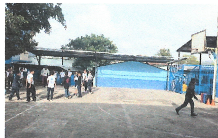
Foto 2: instalacion de costaneras para soporte de lamina
