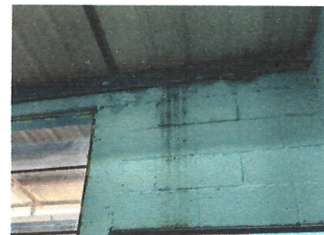
Foto 6: Sellado de lamina en aula de 1ro.
