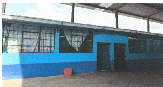
Foto 4: Sustitucion de ventanas de metal , por ventanas de pvc en aulas de primero
