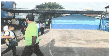
Foto1: Sustitucion de lamina , por lamina troquelada calibre 26
