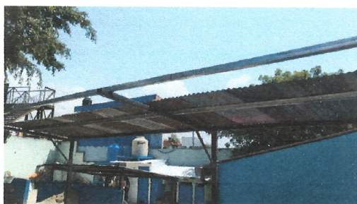
Foto 3: Sustitucion de estructura de metal, por metal con refuerzo de tijeras
