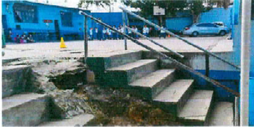
Foto 7 : sustitucion de pasamanos por baranda de metal
