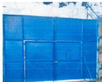
Foto 2: instalacion de techo, para proteccion de porton
