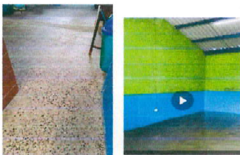
Foto 5: colocacion de piso ceramico en cocina y aula de preprimaria
