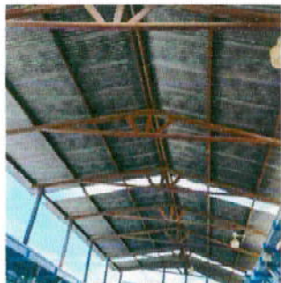
Foto 1: colocacion de laminas faltantes en techo de patio de preprimaria
