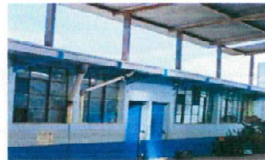
Foto 10: instalacion de balcones a ventanas
