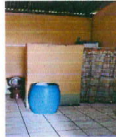
Foto 8: modificacion de sanitarios, colocacion de azulejo , puertas, tuberías de drenaje y agua potable
