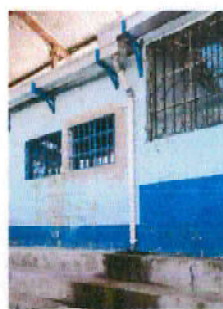
Foto 6: sustitucion de bajada de agua pluvial subterranea
