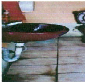
Foto 9: implementacion de lavamanos de concreto en sanitarios de preprimaria
