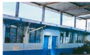
Foto 4: sustitucion de ventanas de pvc, en aulas de preprimaria
